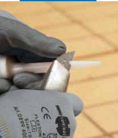
Couper la buse à la dimension souhaitée
