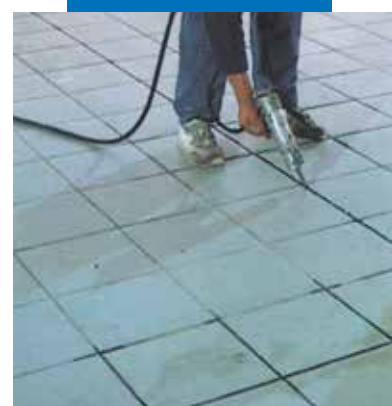
Remplissage des joints de fractionnement
