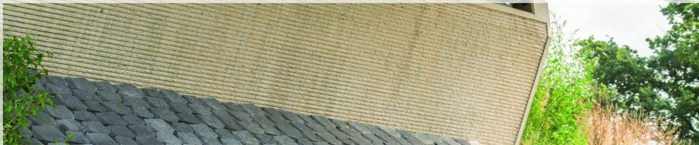
Cette matrice fait partie des structures de style béton bouchardé. Comparativement aux structures bouchardées trapézoïdales, les rainures apparaissent plus fines et arrondies mais moins sophistiquées.
