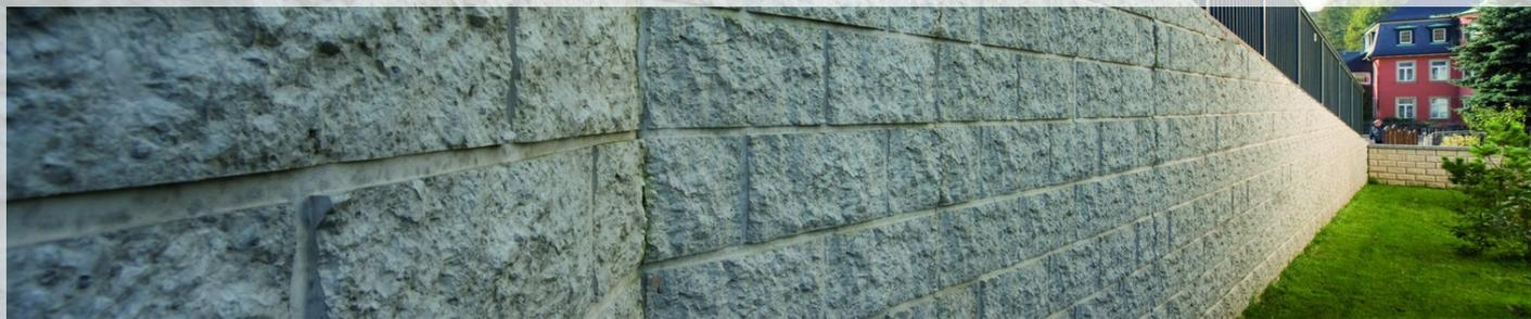
La matrice Kufstein donne l'impression d'un mur en pierres naturelles maçonnées à l'ancienne selon un appareil en panneresses. Le modèle Kufstein est fréquemment utilisé pour les ouvrages de génie civil.
