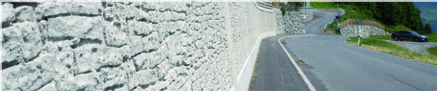
Une structure extrêmement appréciée lorsqu'il s'agit de simuler l'apparence d'un mur maçonné en liaison sauvage en pierre naturelle brisée. Bien souvent, la teinte naturelle propre au béton suffit pour obtenir un rendu convaincant.
