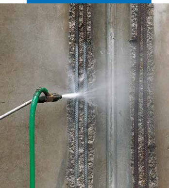
Décapage des fers par hydrosablage
