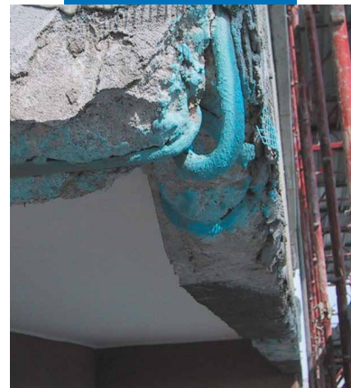
Armatures d'un nez de balcon traitées avec Mapefer 1K
