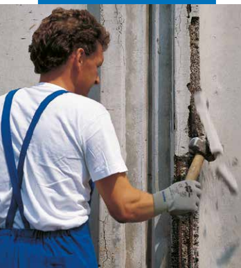
Démolition du béton dégradé
