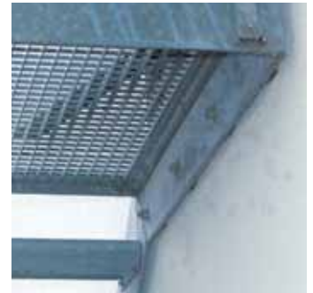
Treppenfestigung mit DB-Ankern
