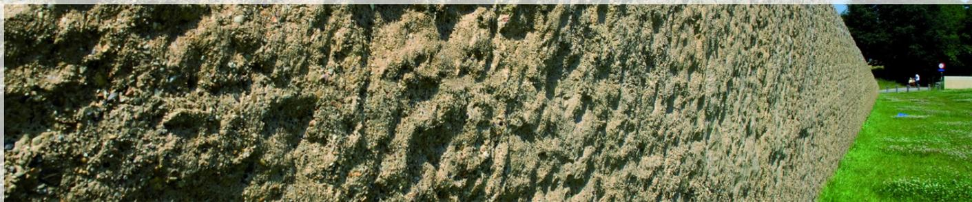
Cette matrice confère au béton l'aspect d'un gros bloc de granite à la surface grossièrement taillée. Comparativement au modèle Granite III, les creux sont nettement plus marqués.
