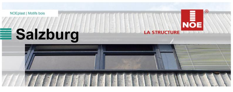
L'empreinte de troncs d'arbres écorcés se reflète dans le béton. Les troncs sont coupés dans le sens de la longueur et peuvent également s'utiliser couchés.
